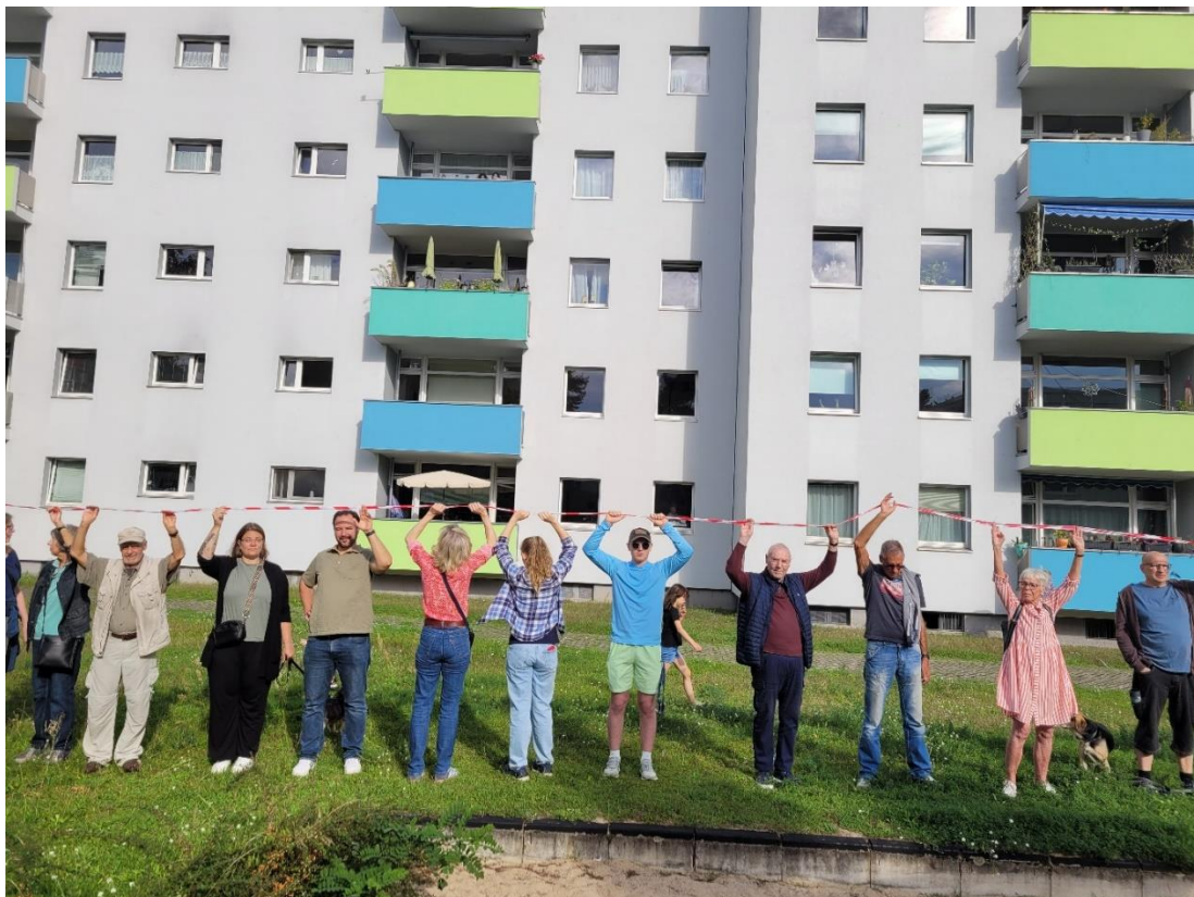
Bild A4-4: Abstand zum Nebengebäude zu gering Neubau Haus A1
