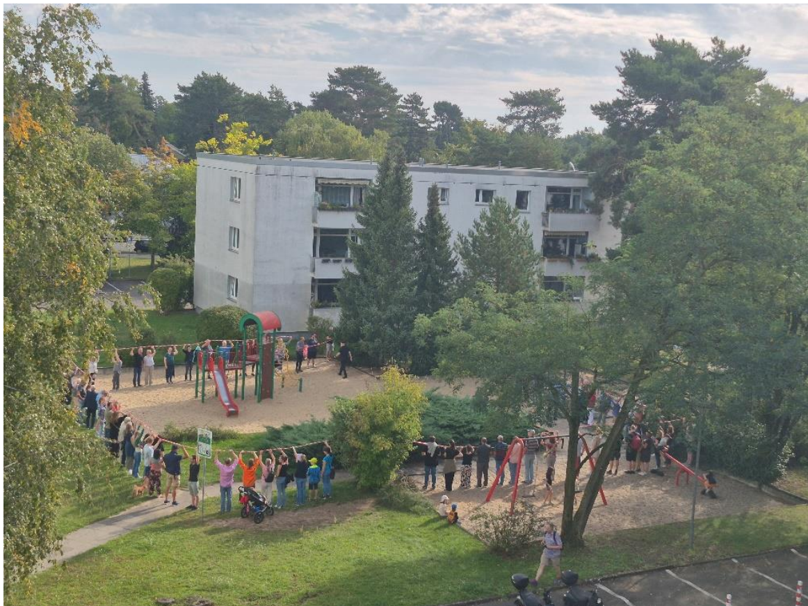
Bild A4-2: Abstand zum Nebengebäude zu gering, drohende Verschattung von Bestandswohnungen, Verlust von Privatsphäre
